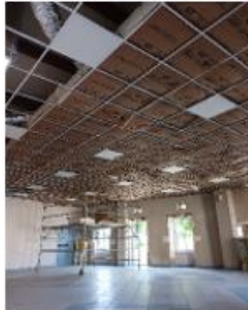
Installation de la laine de verre
