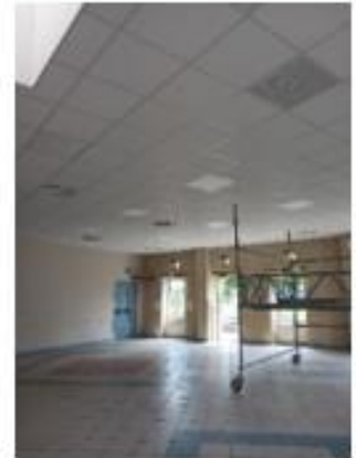
Fin de l'abaissement du plafond
